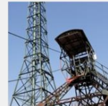
Schachtanlage Kneesebeck Bad Grund
