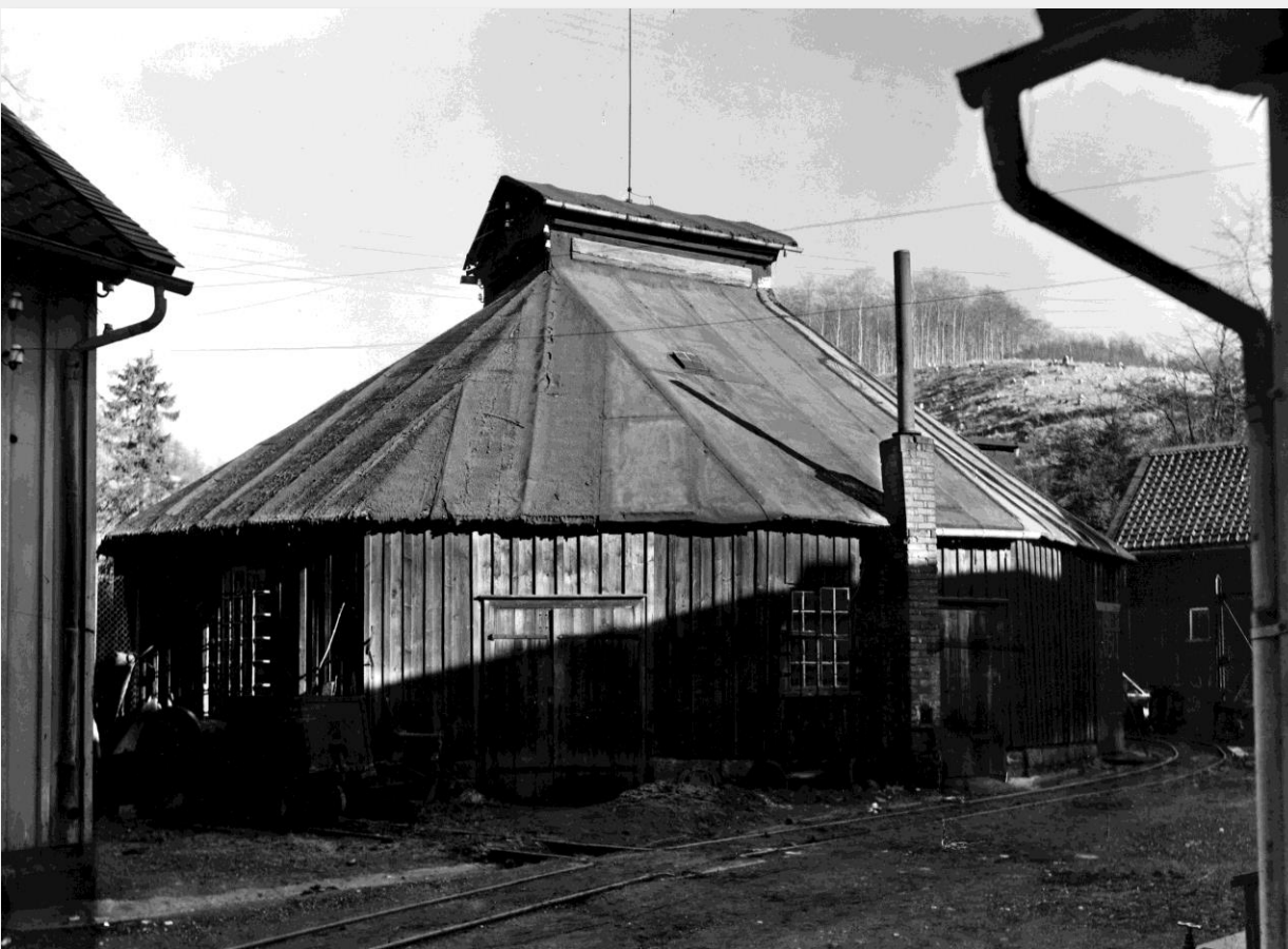
Letzter Harzer Pferde-Gaipel von 1835 Grube Hilfe Gottes in Grund um 1930 transloziert 1935
